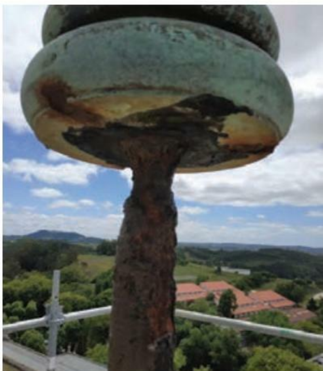
Fig. 54 Pormenor do fuste de sustentação do cata-vento, após desmonte do "galo" © AOF
