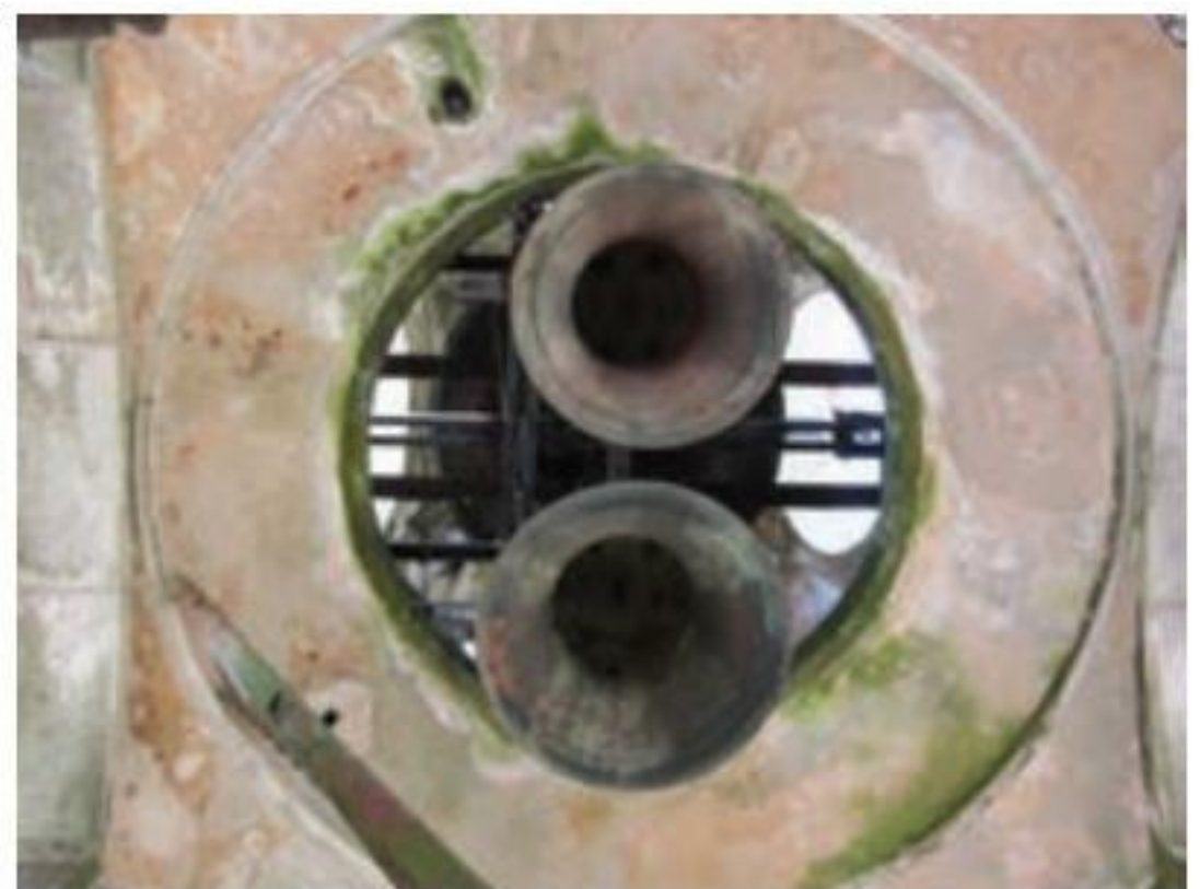
Fig. 9 Abóbada do 3.º nível antes da intervenção © PNM/DGPC
