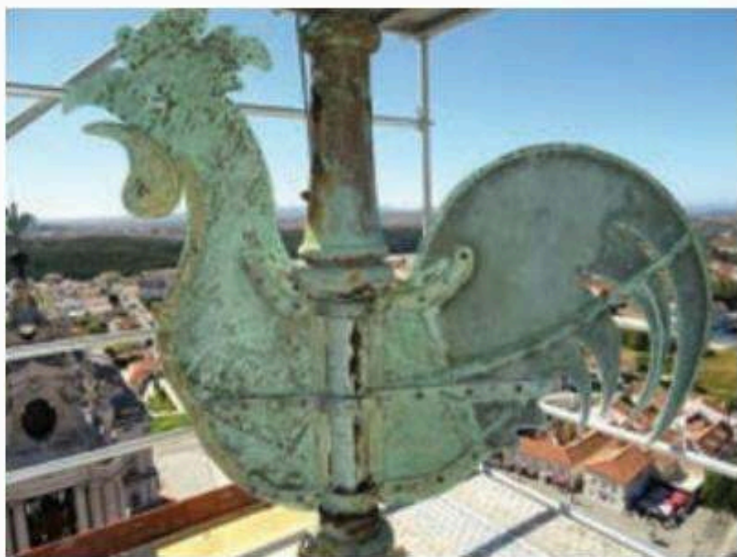
Fig. 11 Cata-vento da torre norte © AOF
