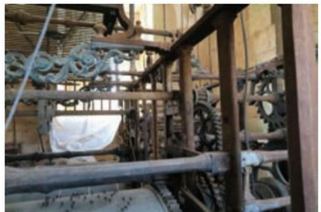
Fig. 20 Relógio da torre norte antes da intervenção © AOF
