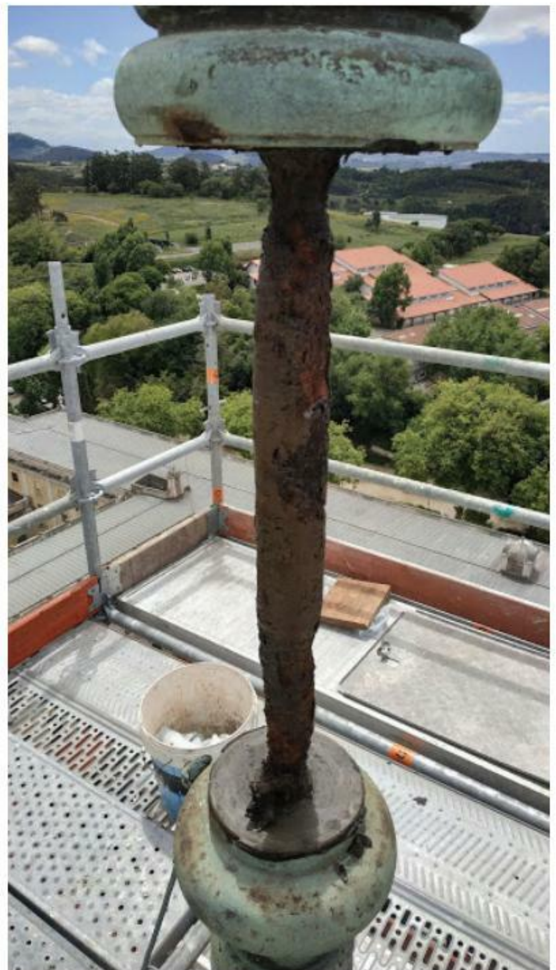
Fig. 53 Pormenor do fuste de sustentação do catavento, após desmonte do “galo” © AOF
