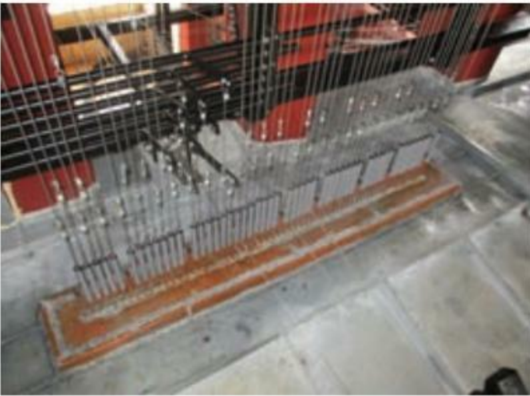
Fig. 42 Novo sistema de transmissão, sistema de toque e sinos do carrilhão sul © AOF
