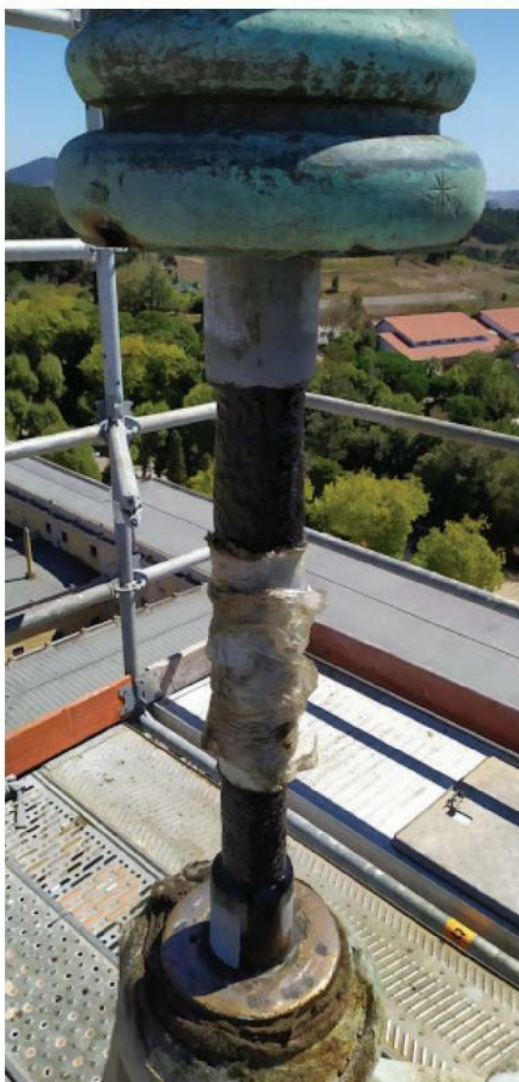
Fig. 55 Reforço do fuste de sustentação © AOF
