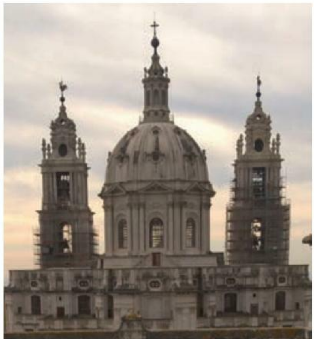
Fig. 4 O zimbório e as torres sineiras em fase de obra, vistas do lado Nascente © Luís Marreiros
