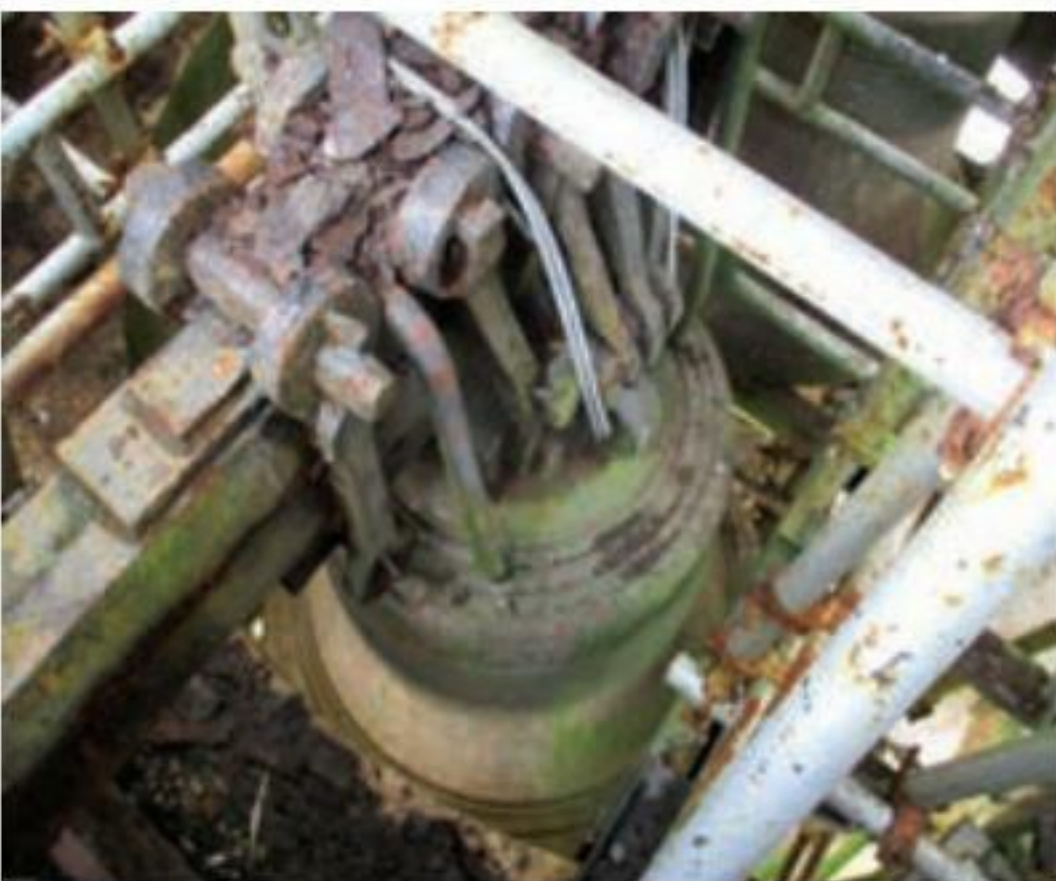
Figs. 51 e 52 Pormenor do estado de fixação e asas dos sinos Bim e Bam © AOF
