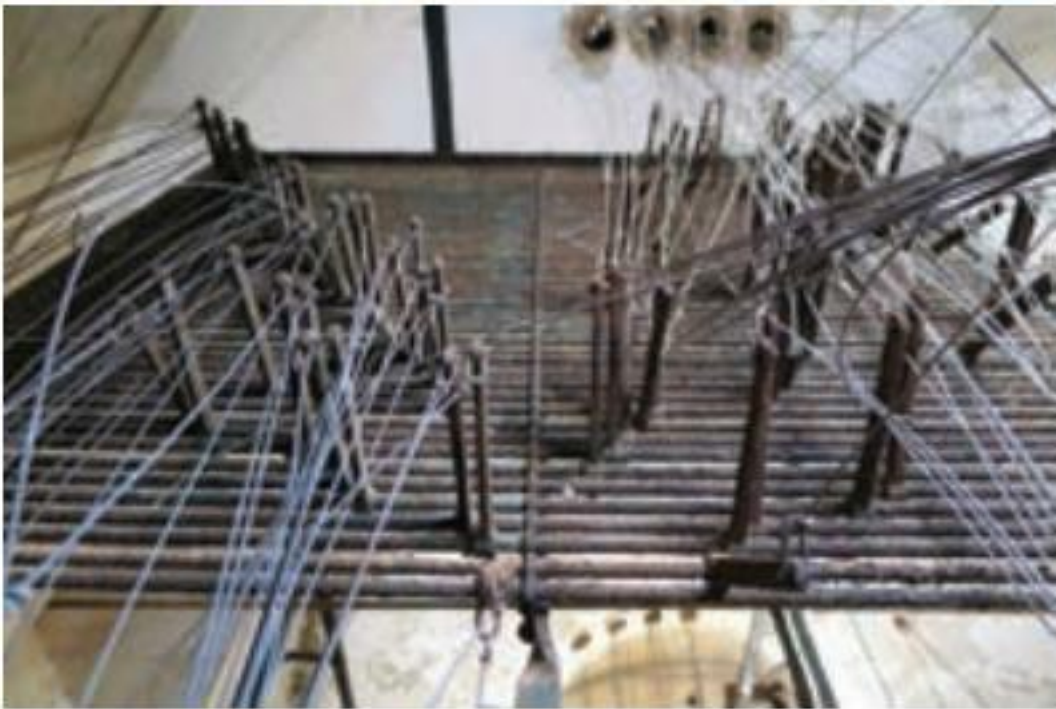
Figs. 21 e 22 Relógio da torre norte antes da intervenção © AOF
