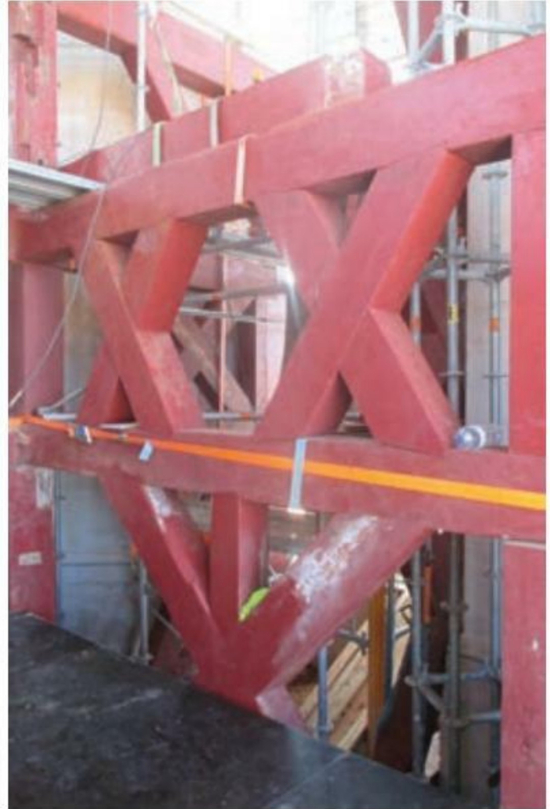
Fig. 18 Montagem da estrutura em obra © AOF
